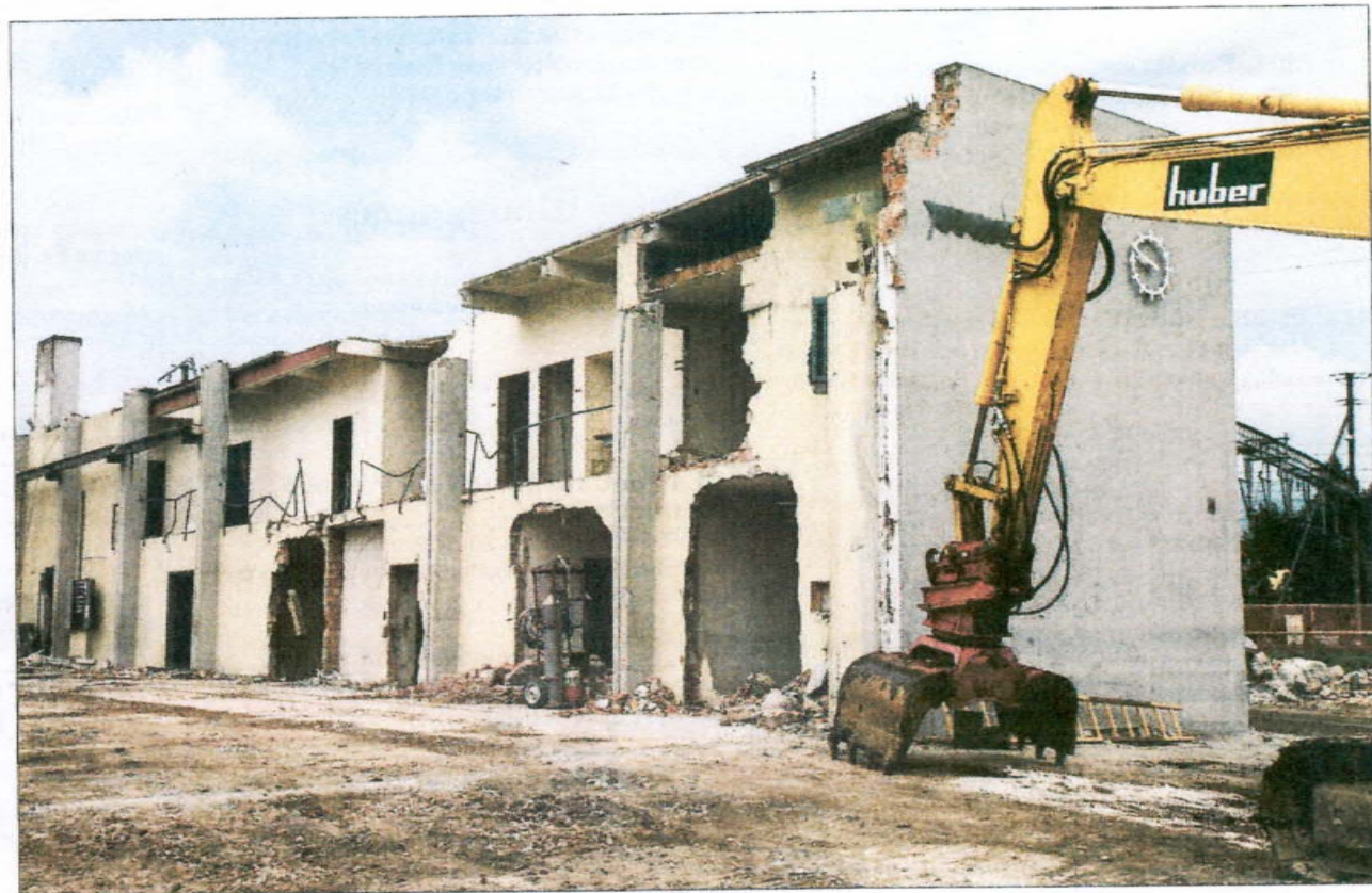
RÜCKBAU Vom alten WSB-Depot ist bald nichts mehr übrig (so sahs gestern aus). PETER SIEGRIST
